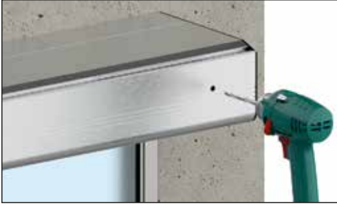
Alüminyum profil delme işlemi. / Aluminium profile drilling operation.
